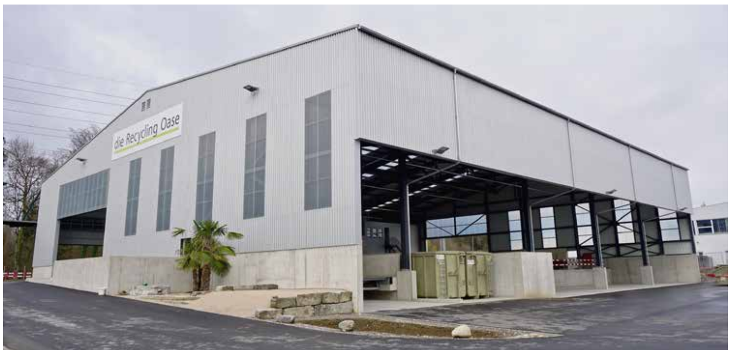
Die 40x50 Meter grosse Halle mit dem Relax-Bereich mit einem Brunnen unter Palmen.
